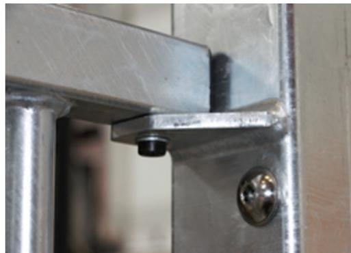
Tous les composants en acier sont fabriqués en acier carbone, soudés en conformité avec la norme EN ISO 5817 et galvanisés à chaud (HDG) selon la norme ISO1461. Ce processus assure une bonne protection en toutes circonstances.
