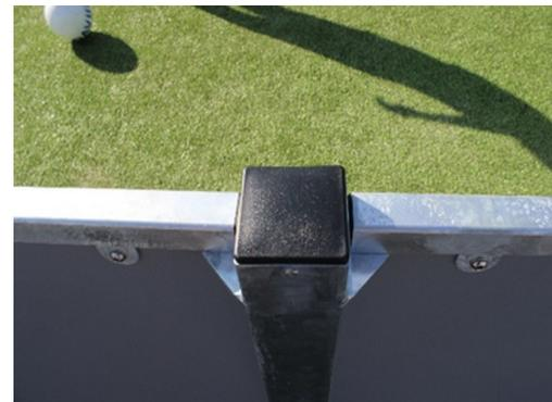
Les poteaux sont des profilés horizontaux de 80 x 80 x 3 mm d'épaisseur, avec des brides soudées de 6 mm. Cela permet une installation facile et une construction solide. Les capuchons de poteau en polyéthylène basse densité sont fixés avec des rivets.
