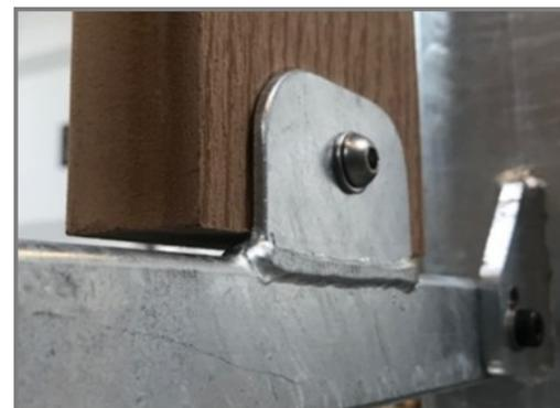
Les panneaux COMPOSITE sont fixés aux brides soudées de 70 x 45 x 3 mm avec des boulons M8, des écrous et des rondelles en acier inoxydable. Ces jonctions ne sont pas visibles de l'intérieur et créent une connexion solide et sûre.
